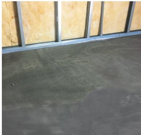
Efter 12-18 timer, når x-plan er gennemhærdet, kan vådrumsmembranen påføres og fliser monteres. Andre gulvbelægnings skal monteres efter leverandørens anvisninger.
