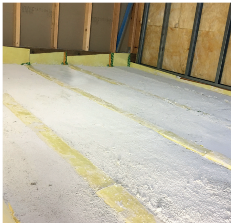
EPS lightbeton 360 udlægges mellem bjælker, og udfyldes til bjælkens overkant. Det er en fordel at prime EPS betonens overflade med 4180 primer før armeringsnet og evt. varmeslanger udlægges
