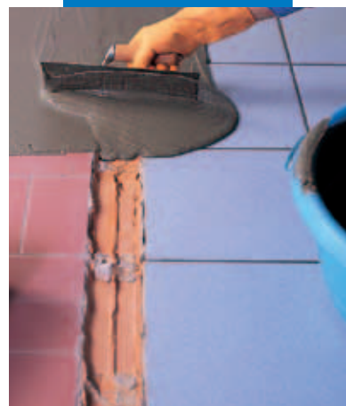
Afretning på eksisterende gulv med Adesilex P4
